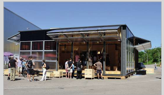
Der fertiggestellte NeighborHub mit teils geöffneten Außenwänden – die Solarpaneele zeigen im geöffneten Zustand fast senkrecht nach oben
